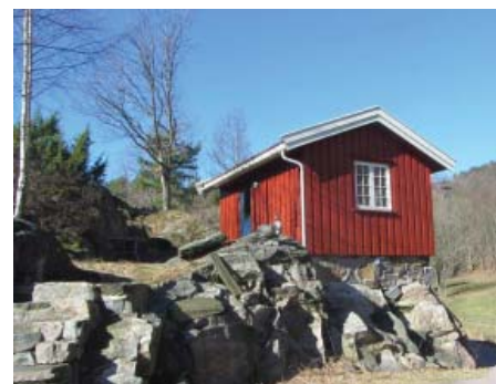
Ett anneks i hagen er bygget om til lager og kontor for NDT Norge.
